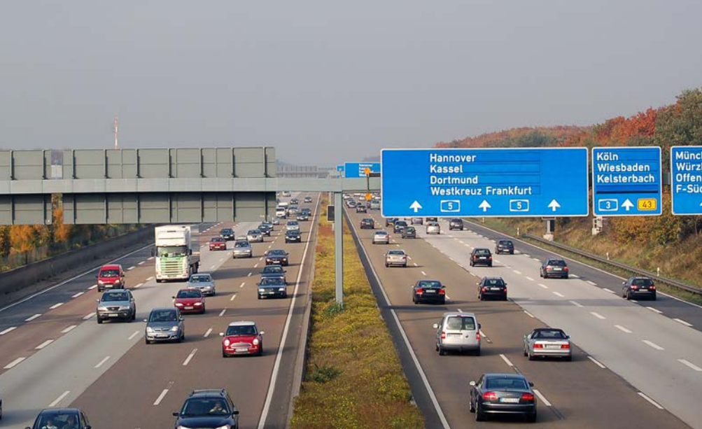
Insgesamt acht Fahrspuren muss der neue Tunnel unter den stark frequentierten Straßen B 43 und A 5 unterqueren.
